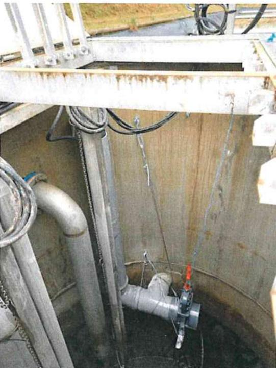
Des détériorations sur la conduite d'eau pluviale sont constatées entre l'école et la station d'épuration, il sera donc demandé rapidement un devis pour remise en état.
